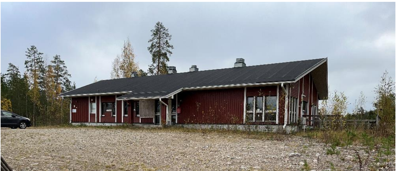
Kuva 3. Entinen laskettelukeskuksen ala-aseman rakennus, jossa on toiminut lipunmyynti, välinevuokraamo ja ravintola.
