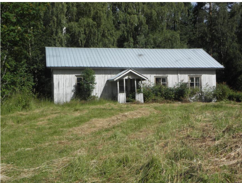
Pellon reunalla on autoio talo.
