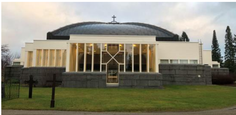
Kuva 8 Lieksan kirkko vuodelta 1982 sijaitsee osana valtakunnallisesti arvokasta rakennettua kulttuuriympäristöä "Pielisen museo ja kulttuuriympäristö". Se on arkkitehtien Raili ja Reima Pietilä suunnittelema arkkitehtonisesti näyttävä rakennus vuodelta 1982.
