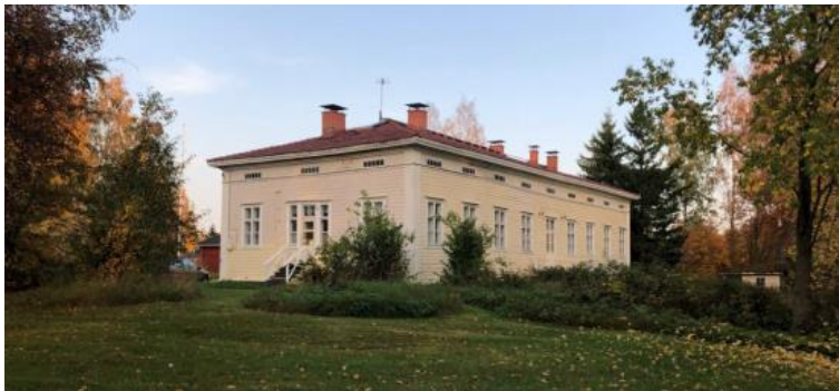
Kuva 9 Hovila, Korpi-Jaakonkatu 1. Hovilan päärakennus on rakennettu Lieksan edellisen kirkon rakentamisen aikoihin vuosina 1834-1848. Se on osa valtakunnallisesti merkittävää rakennettua kulttuuriympäristöä "Pohjois-Karjalan hovit". Hovila on Lieksan kylän vanhin säilynyt asuinrakennus. Tyyliltään empirevaikutteisen rakennuksen on mahdollisesti suunnitellut arkkitehti C.L. Engel.
