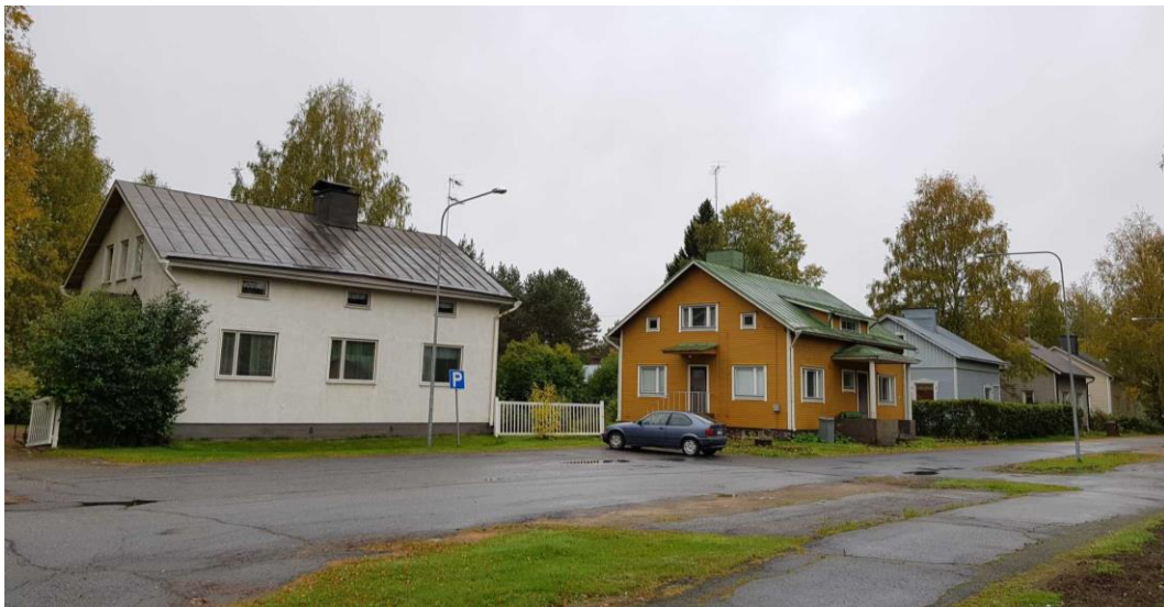
Sotien jälkeen rakennettua asutusta Iljankadun varrella Lieksan keskustan tuntumassa.
