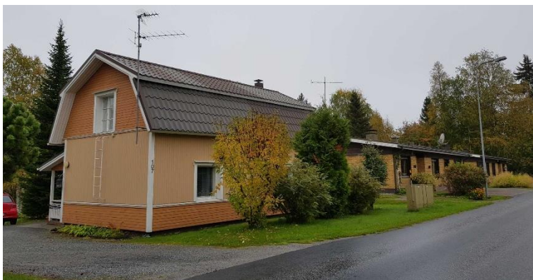
Pielisentie 107. Rakennuksen ikkunat, ulkoverhous ja kate on aikojen kuluessa uusittu. Kattomuoto ja rakennuksen koko kertovat kuitenkin, että kyseessä on 1920-luvun asuinrakennus. Vaikka muutunut rakennus ei ole itsessään arvokas, sillä on arvoa osana 1920-luvun rakennusten alueelle muodostamaa kokonaisuutta.
