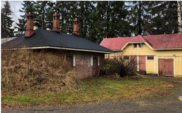
Pihapiirissä on tiilinen maakellari.
