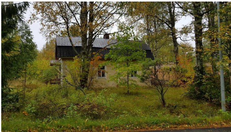
Ainola (Pielisentie 99). Muutamien 1920-luvun rakennusten ominaispiirteet ovat hyvin säilyneet.
