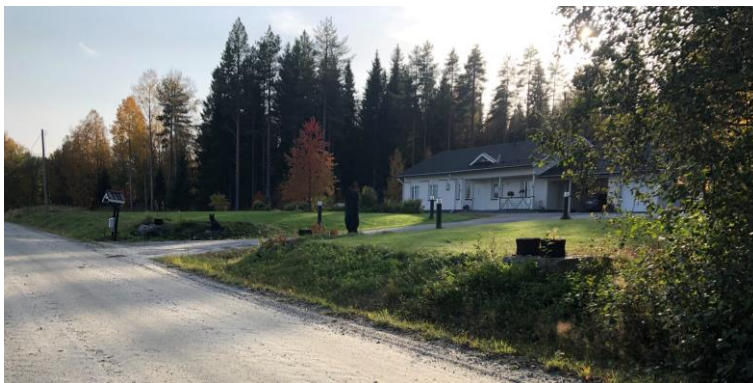
Uudisrakentamista Lepolantien varrella.
