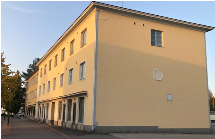
Lieksan kaupungintalon (entisen teknisen viraston) rakennus (kohde 2) muodostuu kahdesta eri-ikäisestä osasta. Niistä vanhempi on rahu-tietojen mukaan valmistunut vuonna 1934, uudempi oletettavasti 1950-luvulla.
