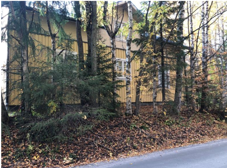
Alueen vanhinta vuosisadan vaihteen rakennuskantaa edustava hirsirakennus Lepolantien reunalla.
