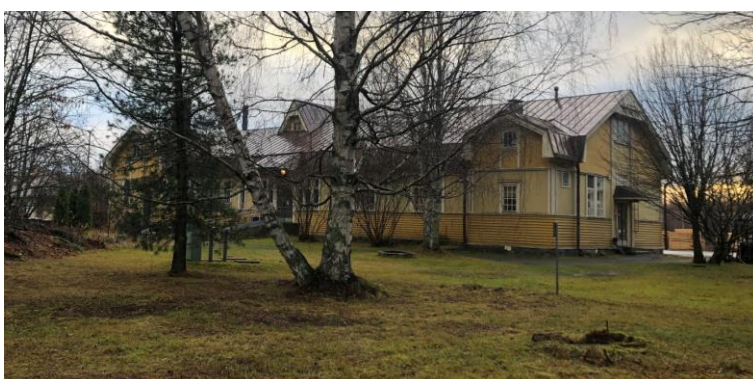
Jugend-tyylinen asemarakennus on valmistunut vuonna 1908.
