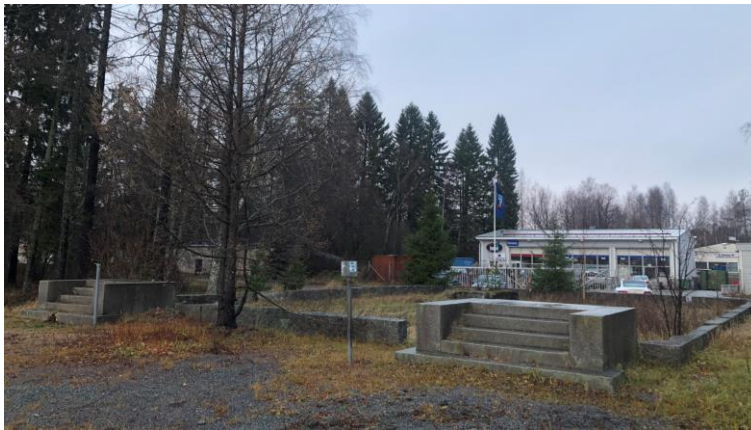
Asemarakennuksen pohjoispuolella on säilynyt vanha kivijalka ja sisääntulojen graniittiset portaikot.
