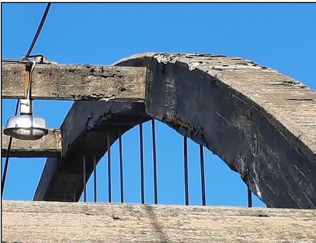
Kuvat 6 ja 7. Vauriokuvia betonikaarista.
