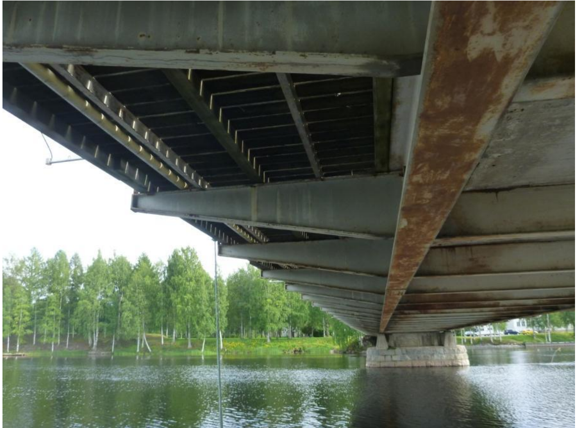
Kuva 28. Levennyksen kantavat rakenteet.
