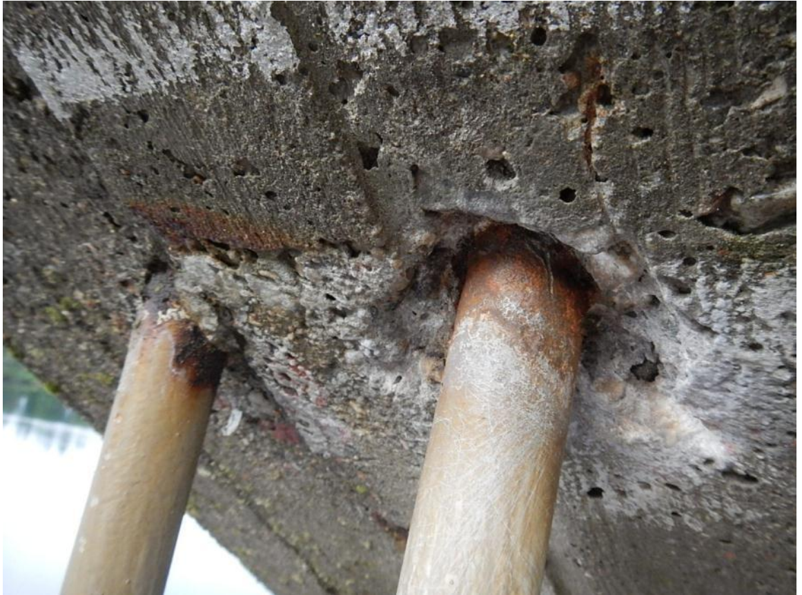
Kuva 29. Vetotangon yläpäähän kiinnitys.
