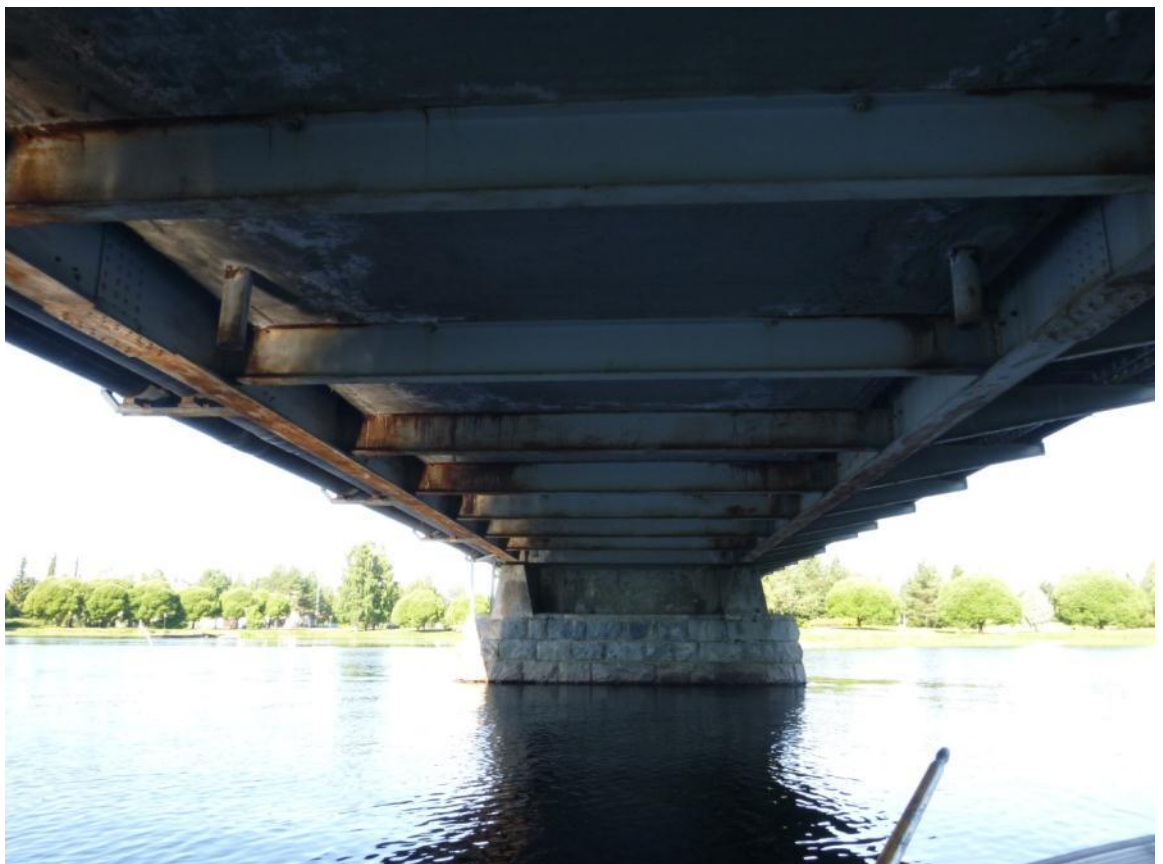
Kuva 3. Yleiskuva sillan alta.
