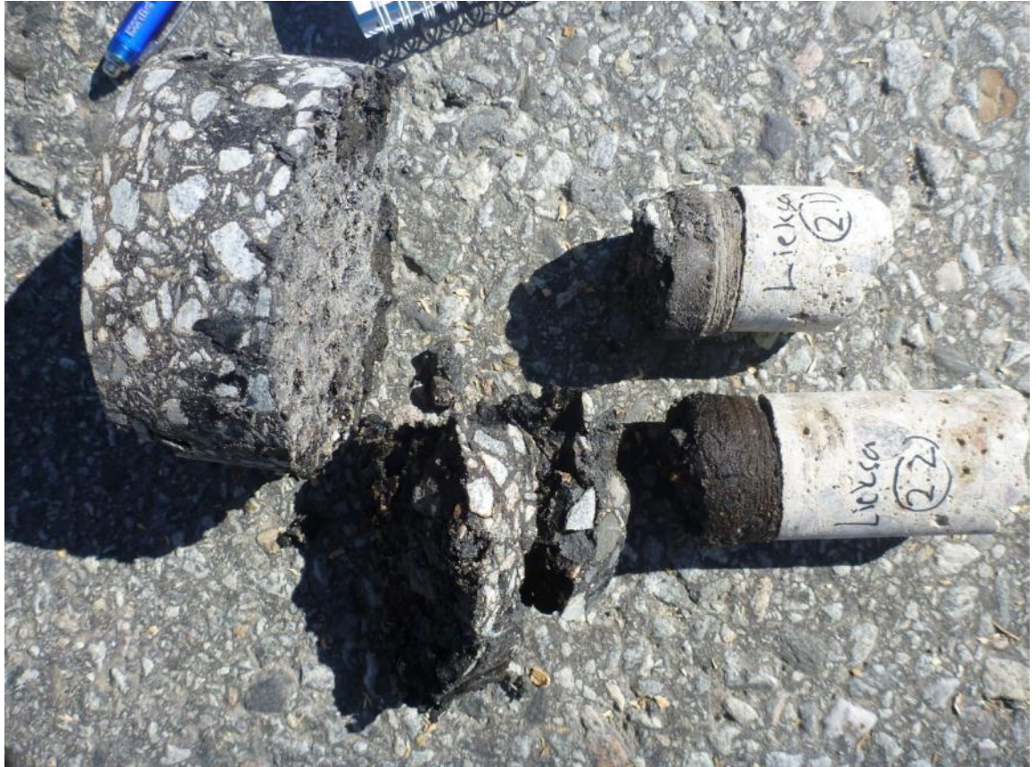
Kuva 36. Pintarakenteet avauskohdassa 2 (T1 + 35,8 m, oik. suisteparru +0,5 m).
