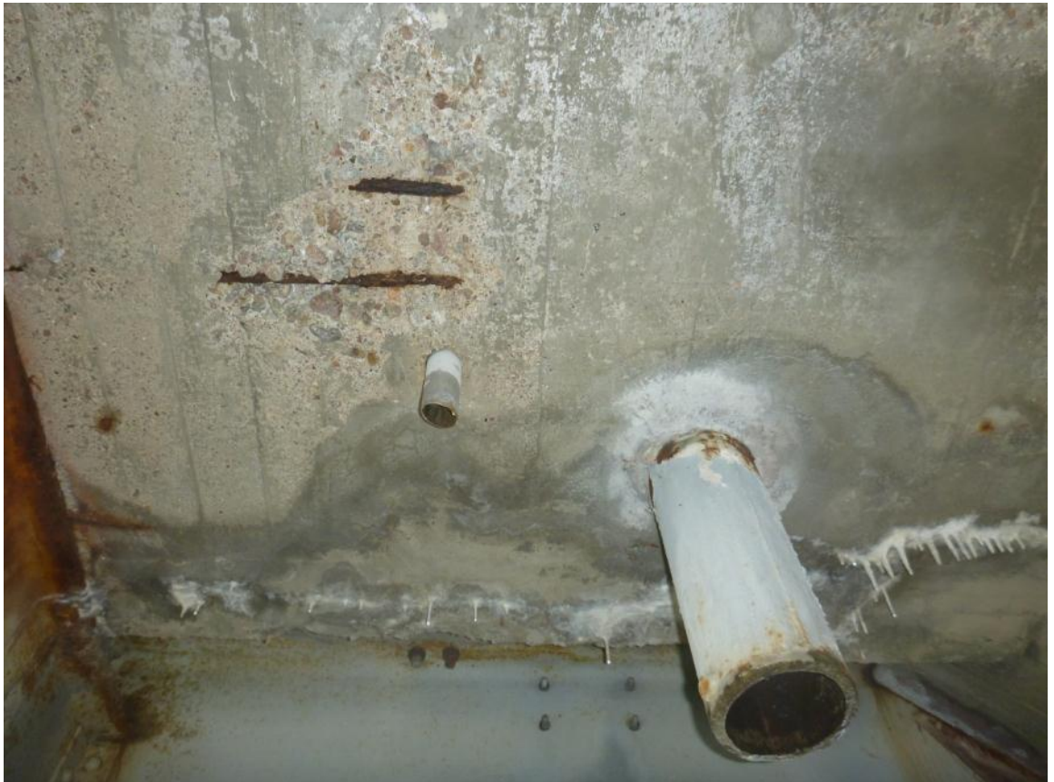
Kuva 43. Pintavesiputki ja tippuputki kannen päässä.
