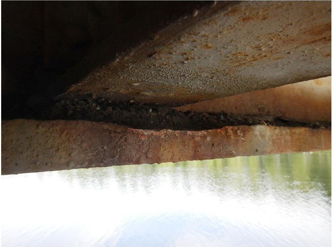
Kuva 34. Kuvassa poikkipalkin alle on kertynyt likaa ja alalaipan yläpinnassa vakavaa syöpymää 7...9 mm
