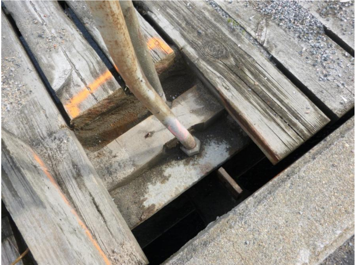
Kuva 30. Puhdistettu vetotankojen alapään liitoskohta.
