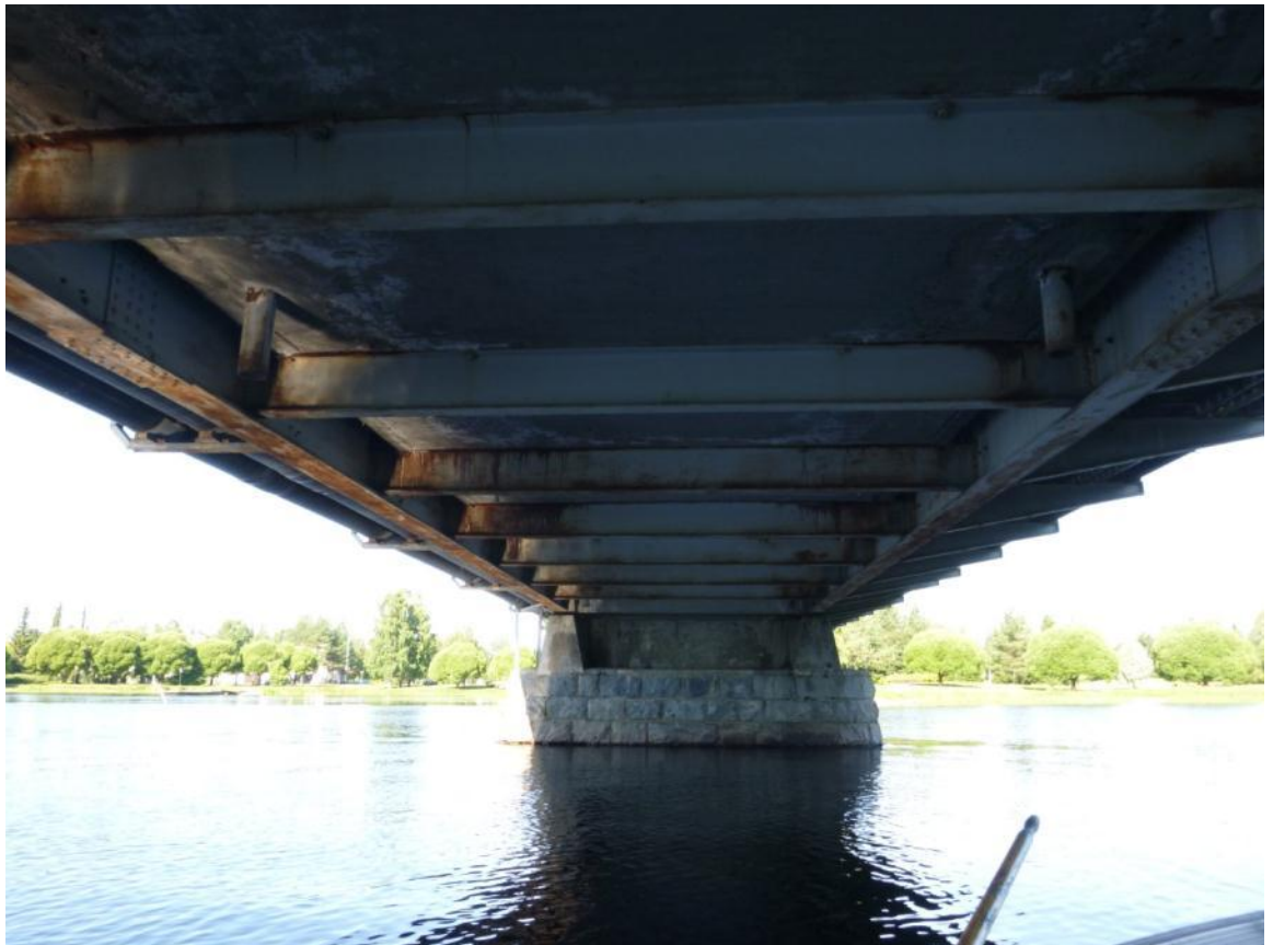
Kuva 3. Yleiskuva sillan alta.
