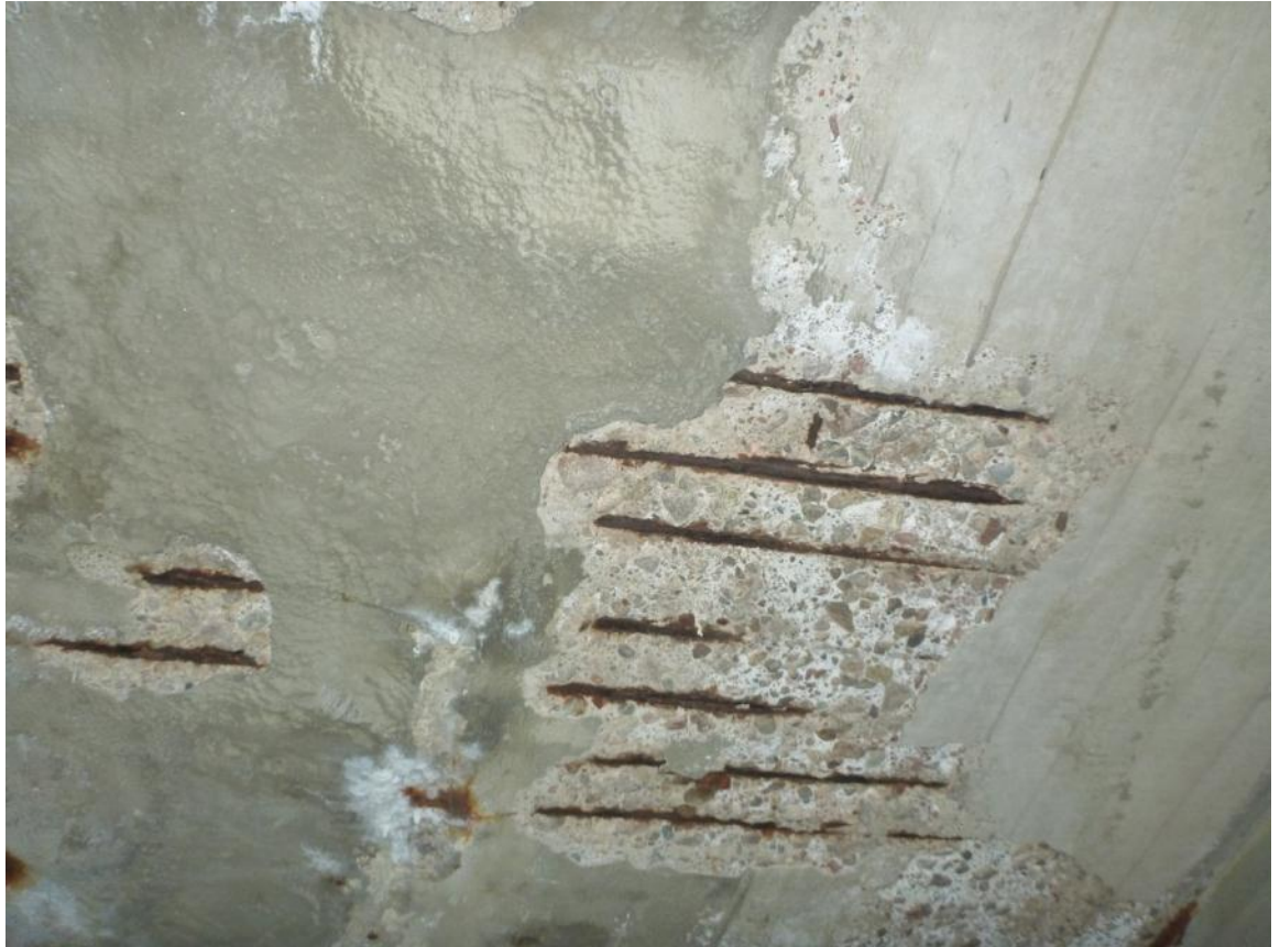
Kuva 24. Kansilaatan erittäin vakavaa ruostumista.
