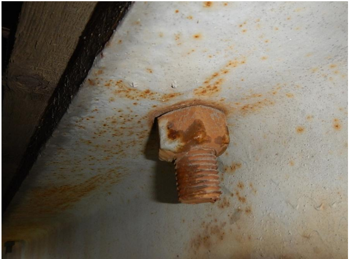
Kuva 32. Kuvassa on löystyneen tangon alamutteri. Tämä tanko ei kannaa.
