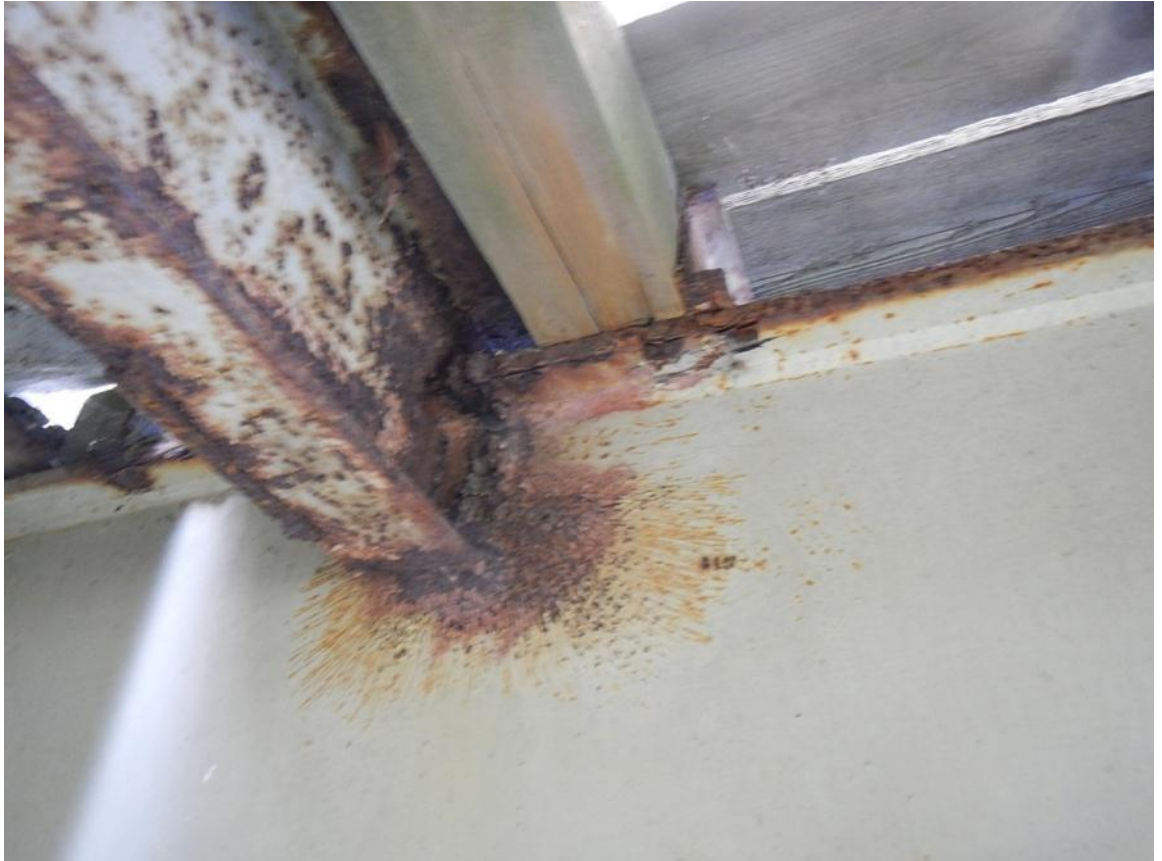
Kuva 35. Kevyenliikenteen levikettä maatuella kantavan palkin hitsiliitos.
