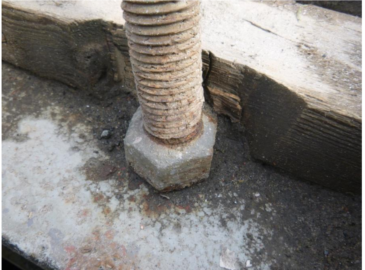
Kuva 31. Tanko on jo käytännössä poikki. Kapasiteettia ei enää ole.
