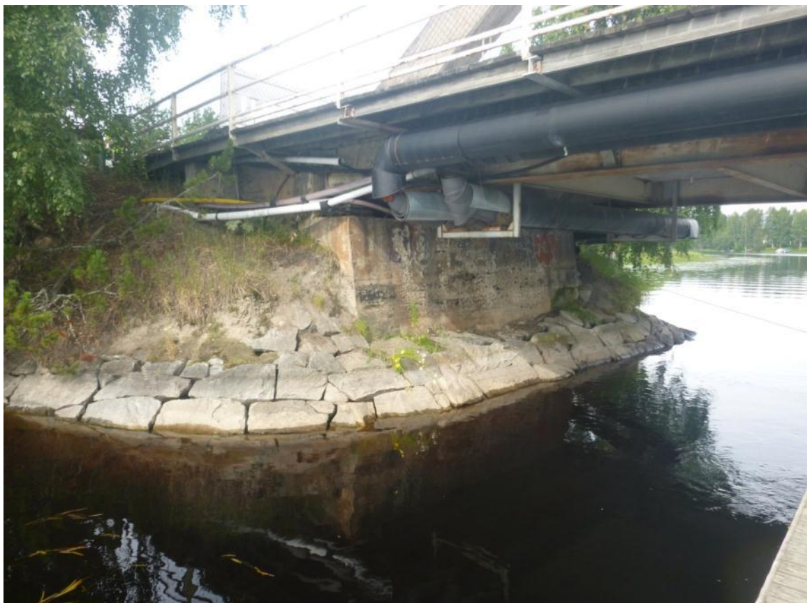
Kuva 45. Kaukolämpöputket koukkaavat maatuen edestä sillan toiselle puolelle.
