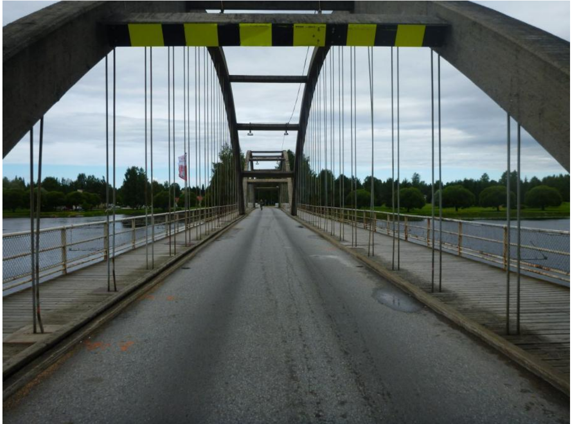
Kuva 2. Yleiskuva sillan päältä Rantalasta keskusta.
