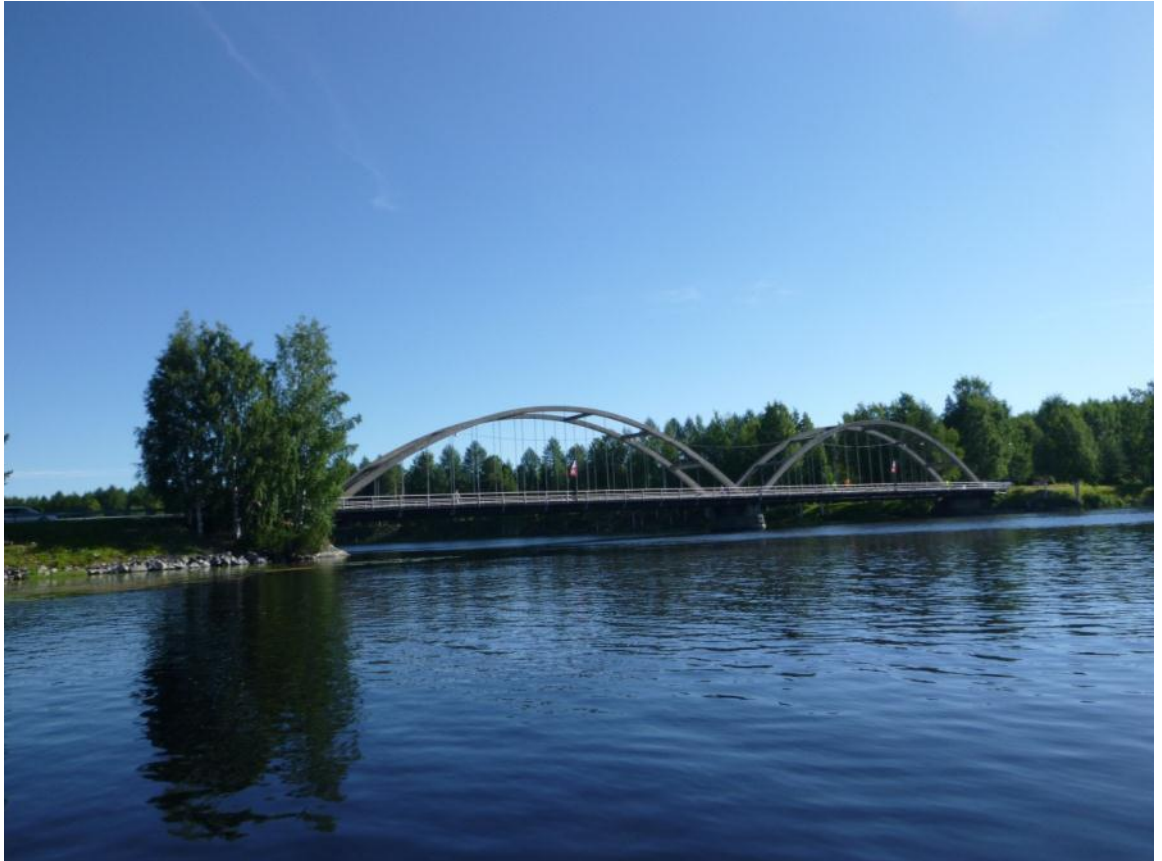
Kuva 4. Yleiskuva sillan oikealta sivulta.
