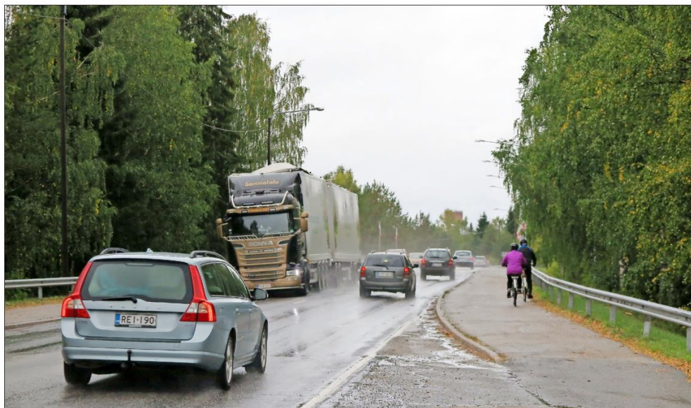
Lieksanjoen ylittävän kantatien sillan liikennemäärä on tuhansia ajoneuvoja vuorokaudessa. Liikenteen estyessä raskas rekaliikenne joutuu kiertämään Pielisen länsipuolen kautta. KUVA: MARJA MÖLSÄ
