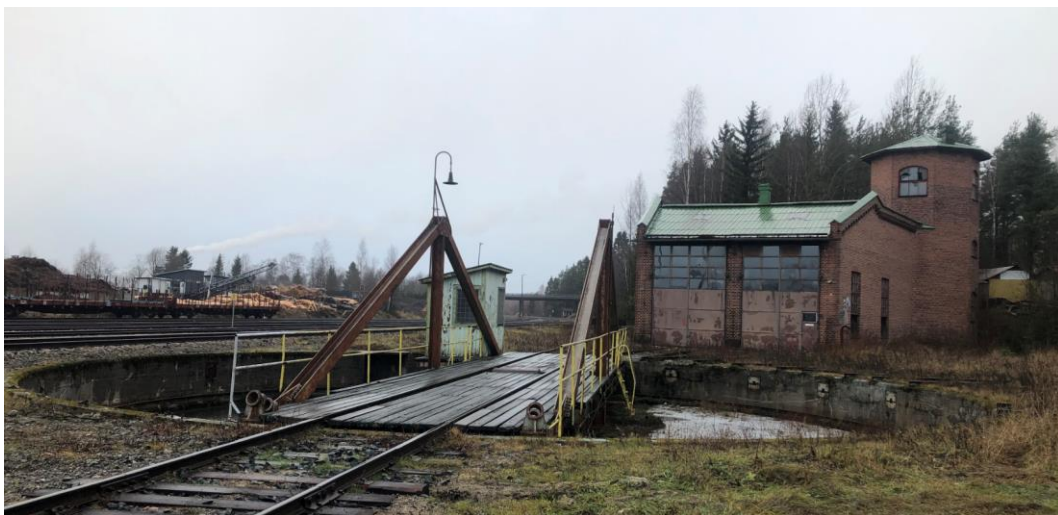
Kaksipilttuinen veturitalli (kohde 56) sijaitsee maakunnallisesti arvokkaaksi tunnistetun rajauksen pohjoispuolella, mutta on merkittävä osa rautatien kulttuuriympäristöstä kertovaa kokonaisuutta.
