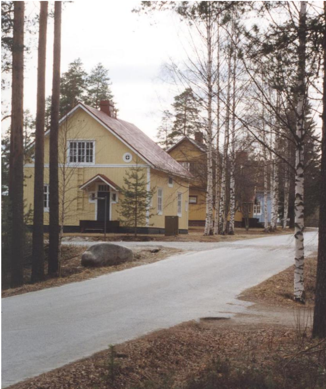
Näkymä Pankakosken Heittopellontieltä. Kadun varrella näkyy kolme neljästä yhtiön 1930 rakennuttamasta työväenasuntotalosta, joissa kussakin oli kolme kahden huoneen asuntoa. Talot ovat vasemmalta oikealle Kuovi, Kurki ja Riekko. Kuovi on vaalenkeltainen, Kurki sinapinvärinen ja Riekko vaaleansininen. Nykyisin rakennukset ovat yksityisomistuksessa. Kadun varrella kasvaa koivuja ja mäntyjä. Pielisen museo. Pankakosken koulun oppilaat ja opettajat, Valokuvaajat 1995–1999. (Kuvälähde: finna.fi).
