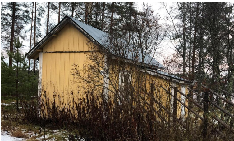
Hangastie 11 rakennus on vuodelta 1925.
