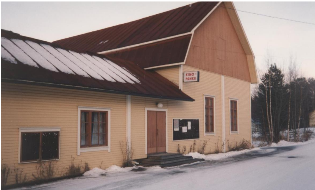
Pankkosken työväentalo Hangaspurolla. Mansardikattoisessa hirsirakennuksessa on matalampi harjakattoinen siipi. Päättyseinässä on kyltti "Kino Pankko" sekä ilmoitustaulu vieressä. Pielisen museo. Pankkosken koulun oppilaat ja opettajat, Valokuvaajat 1995–1999. (Kuvälähde: finna.fi).
