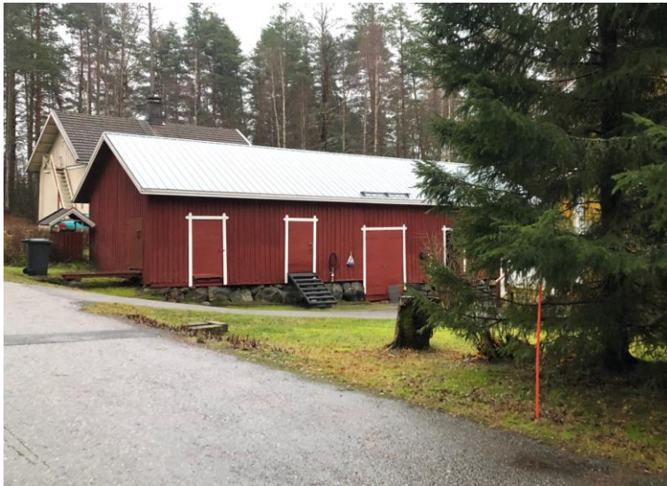
Kohteen 73 asuinrakennukset ja talousrakennus ovat 1890-luvun lopulta. Ainoat rakennuskokonaisuudesta säilyneet.
