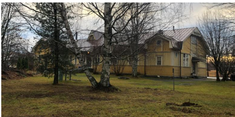
Jugend-tyylinen asemarakennus on valmistunut vuonna 1908.
