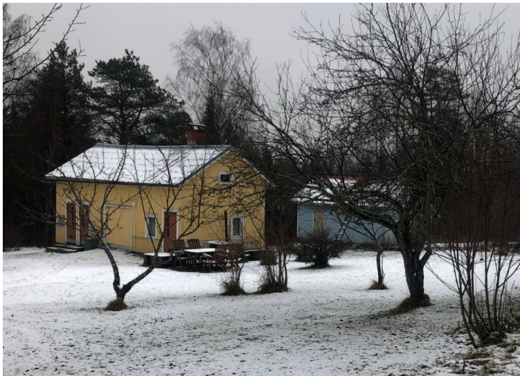
1960-luvun talousrakennuksia Rasinkujalta.
