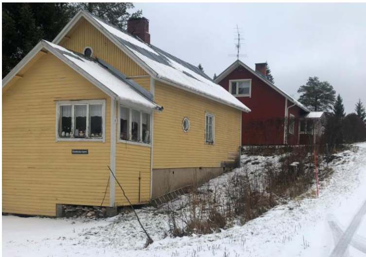
Hyppyrintien varren 1930-luvun rakennuksia.
