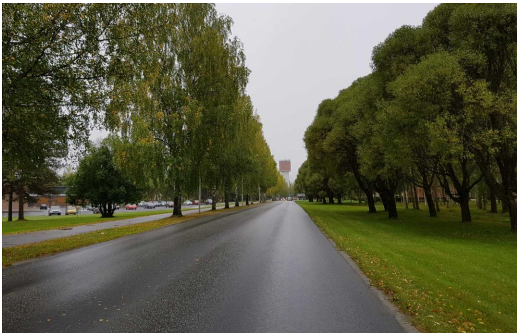
Lieksan vesitorni on rakennettu vuonna 1955. Se on tärkeä maamerkki, joka näkyy eri puolille kaupunkia. Katukuvassa vesitorni näkyy mm. Kainuuntien ja Asemakadun puistoakselien päätteellä.
