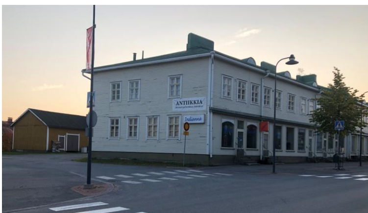
Pielisentie 36 ja piharakennus (kohde 10). Rakennus valmistui Pielisentie 38:n viereen vuonna 1935. Rakennuksessa on liike- ja asuinhuoneistoja. Julkisivuihin on tehty muutoksia 1940-luvun lopulla ja 1950-luvulla.
