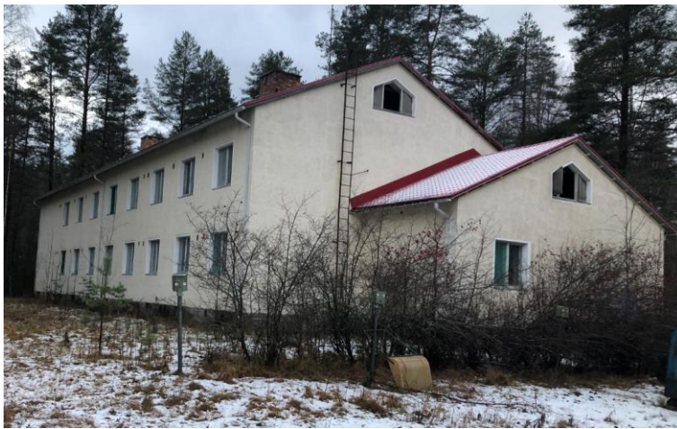
1950-luvun koulurakennuksen eteläpuolella sijaitsee kaksikerroksinen pienkerrostalo, joka on todennäköisimmin ollut alkujaan opettajien asuntola.
