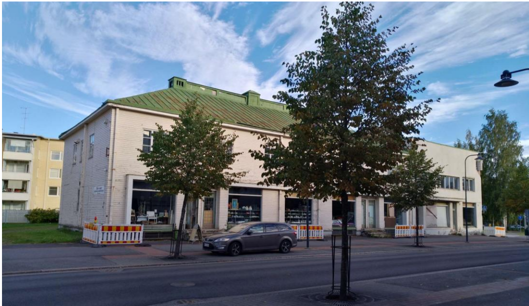
Pielisjärven Osuusliikkeen vanhempi, vuonna 1925 valmistunut rakennus on yksi harvoista paloa edeltäneeltä ajalta säilyneistä rakennuksista Lieksan keskustassa.
