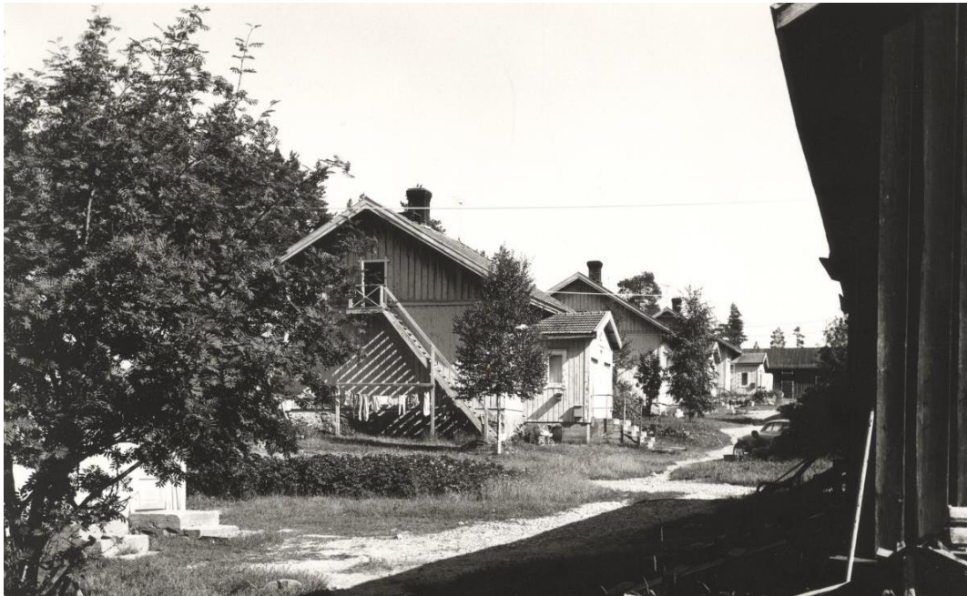
Pankakosken Vanhan Niskan työläisasuntoja. Vasemmalla on vaaleaksi maalattujen puutalojen rivi, oikealla näkyy vähän ulkorakennuksen seinää. Pielisen museo. Valokuvaaja Erkki Kutvonen. (Kuvälähde: finna.fi).
