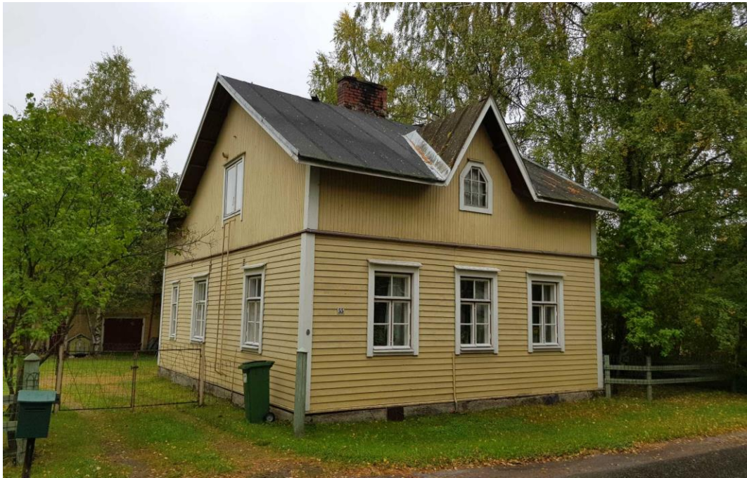
1920-luvun rakennusperinnettä edustava asuinrakennus, Pielisentie 55, erottuu kohokohtana katumiljöössä.
