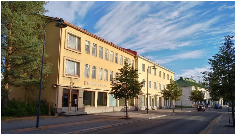
Lieksan kaupungintalon (entisen teknisen viraston) rakennus (kohde 2) muodostuu kahdesta eri-ikäisestä osasta. Niistä vanhempi on rahu-tietojen mukaan valmistunut vuonna 1934, uudempi oletettavasti 1950-luvulla.
