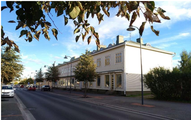
Pielisentie 38 (kohde 9) on rakennettu asuin- ja liiketaloksi vuonna 1935.
