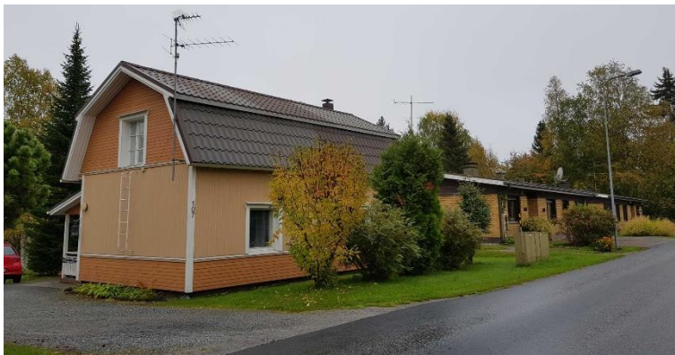
Pielisentie 107. Rakennuksen ikkunat, ulkoverhous ja kate on aikojen kuluessa uusittu. Kattomuoto ja rakennuksen koko kertovat kuitenkin, että kyseessä on 1920-luvun asuinrakennus. Vaikka muutunut rakennus ei ole itsessään arvokas, sillä on arvoa osana 1920-luvun rakennusten alueelle muodostamaa kokonaisuutta.
