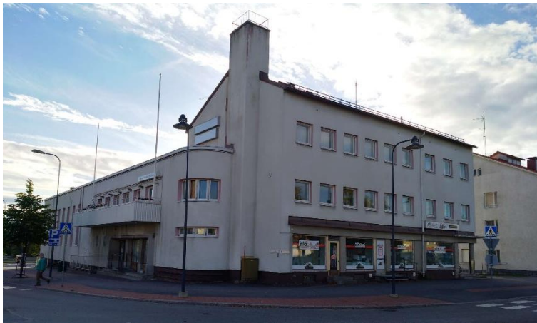
Pielisentie 44 (kohde 6). Vuonna 1938 rakennettu Kulman talo on järjestyksessä kolmas tyväentalo samalla paikalla. Alun perin kaksikerroksisessa rakennuksessa oli teatterisali, kahvila ja ravintola, Pielisentien puolella oli Pielisjärven yleisen osuusliikkeen myymälä. 1950-luvulla taloon rakennettiin kolmas kerros, johon tuli hotellihuoneita.
