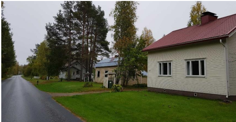
Vehkakankaan alueella sijaitsevat 1920-, 1930- ja 1950-lukujen rakennukset muodostavat kiinnostavan, kerroksellisen miljöö.
