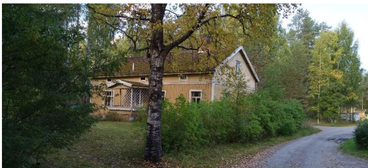
Aittapolkua reunustavat 1900-luvun alun asuinrakennukset.
