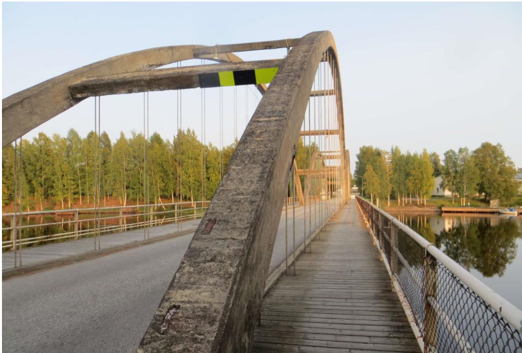
1920-luvulla rakennettu Mähköntien kaarisilta on tärkeä maamerkki jokimaisemassa.
