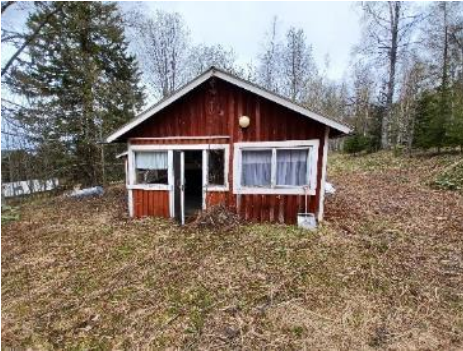
Kuva 10. 1900-luvun alkupuolella rakennettu asuinrakennus. (Kuva: Lieksan kaupunki)
