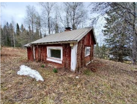
Kuva 9. 1900-luvun alkupuolella rakennettu asuinrakennus (Kuva: Lieksan kaupunki).
