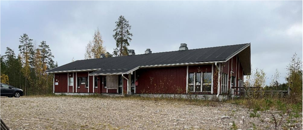
Kuva 2. Entinen laskettelukeskuksen ala-aseman rakennus, jossa on toiminut lipunmyynti, välinevuokraamo ja ravintola.
